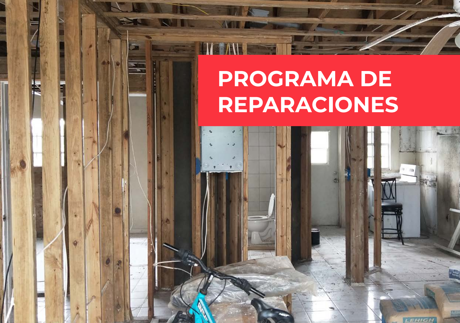
Reparaciones siendo realizadas al interno de una vivienda en Ábaco, abril de 2020 Fuente: FICR
