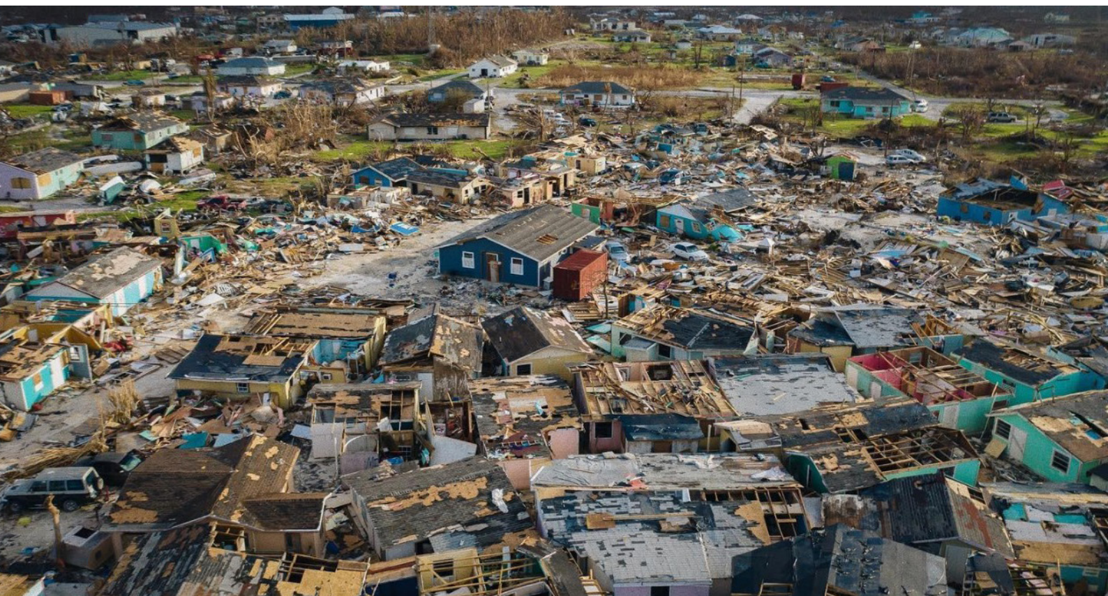
Daños a viviendas causados por el huracán Dorian en la isla de Ábaco, Bahamas, 2019, Fuente: FICR
