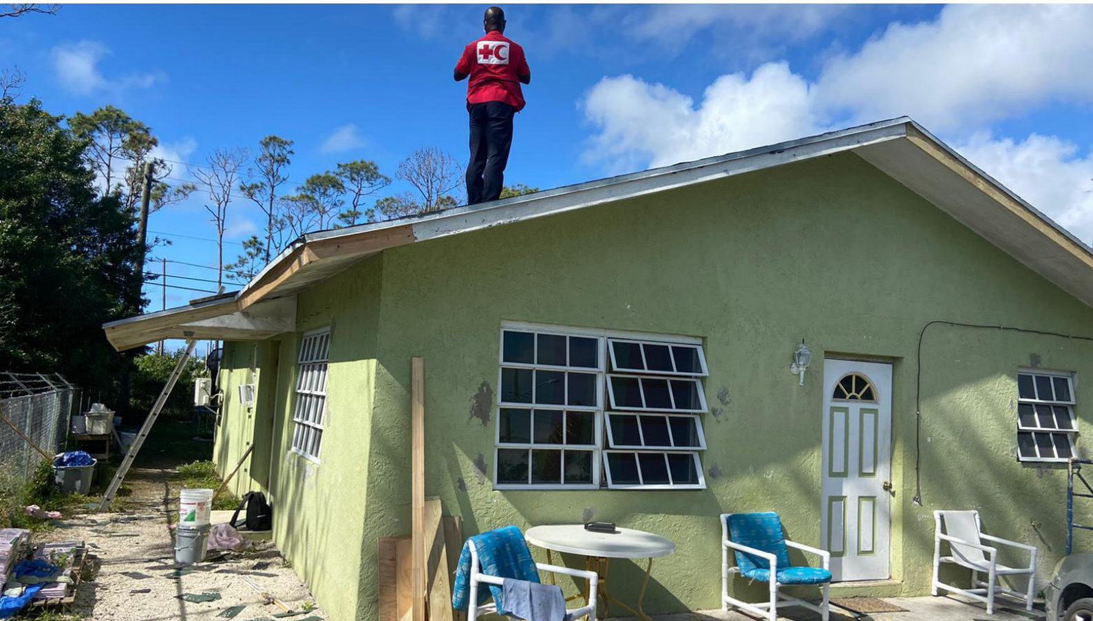
Evaluación para reparación de un techo en Gran Bahama, mayo de 2021 (Fuente: FICR)
