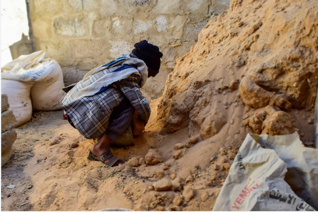
مراد يساعد ابيه في اصلاح سقف المنزل- مديرية عيال سريح / عمران
